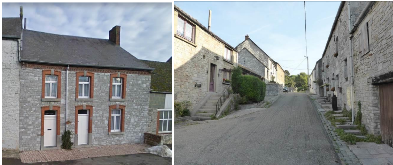
Figure 85 : Bâti traditionnel à gauche (Source : Google Street View) et espace-rue à droite (photo : DR(EA) 2 M)
