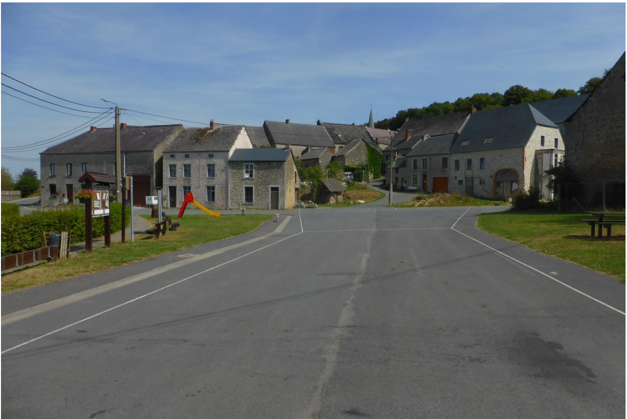
Figure 181 : Rue du Quairiat (Photo : DR(EA) 2 M)
