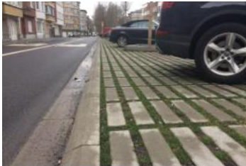
Figure 6: Système alvéolaire pour gazon et pavés à joints ouverts (Source : Bruxelles Environnement, 2019, Guide du Bâtiment Durable : Revêtements Perméables)
