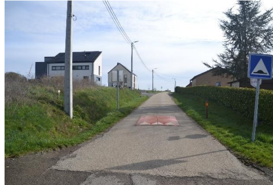
Figure 12 : dispositif de ralentissement rue des Terres aux Pierres, Sautour (Source : DR(EA) 2 M, 2023)
