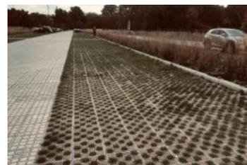
Figure 8: Aménagement écologique d'un parking (Source : Ibram Nobels, 2019, Guide du Bâtiment Durable : Revêtements Perméables)
